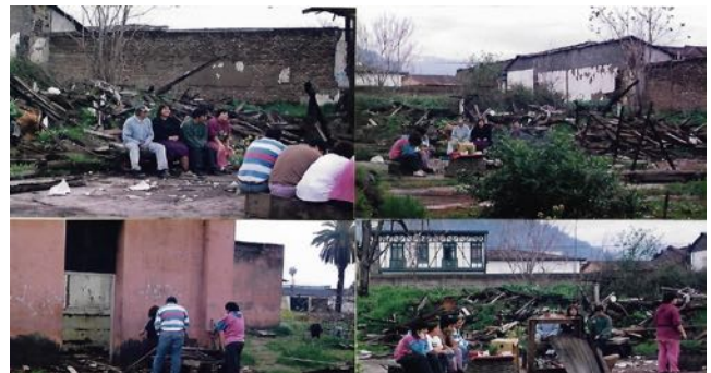
Pabellones de crónicos derrumbados por el terremoto en el Hospital Psiquiátrico
